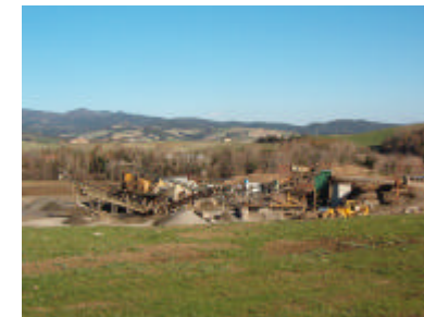
Foto 1. Impianto di lavorazione
